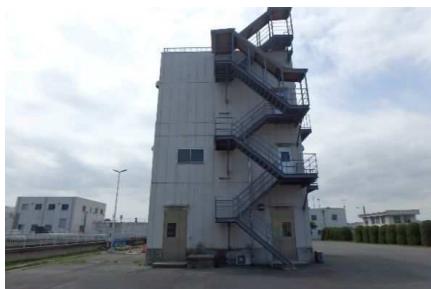
粉末活性炭注入機棟
