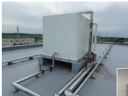
管理本館（高架水槽）
